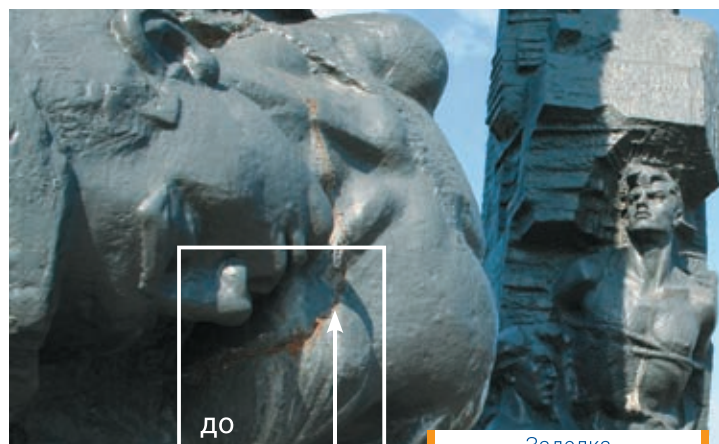
Заделка трещин в монументе
