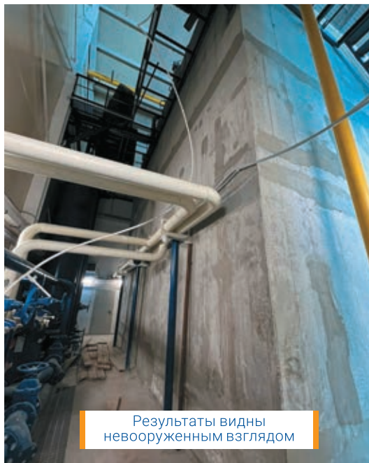
Инъектирование «Пенепурфом 1К»
