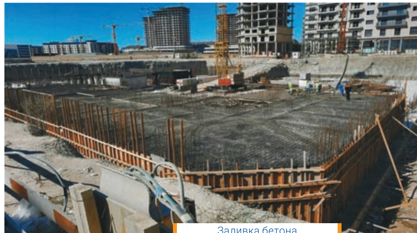
Заливка бетона с «Пенетрон Адмиксом»
