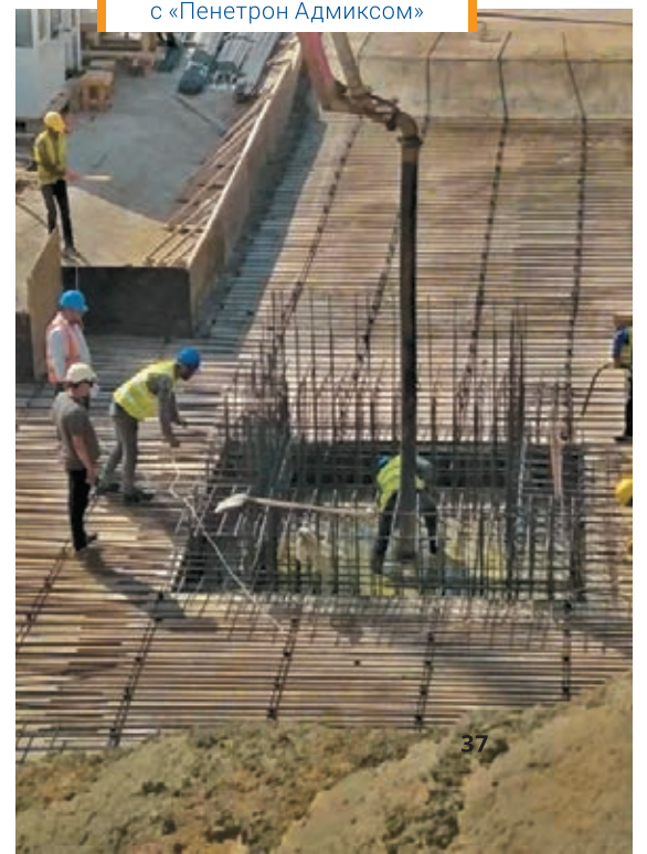
Заливка бетона с «Пенетрон Адмиксом»
